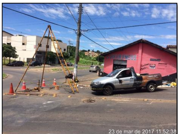
Foto 05 - Sondagem Furo nº5
