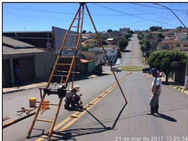
Foto 01 - Sondagem Furo nº2
