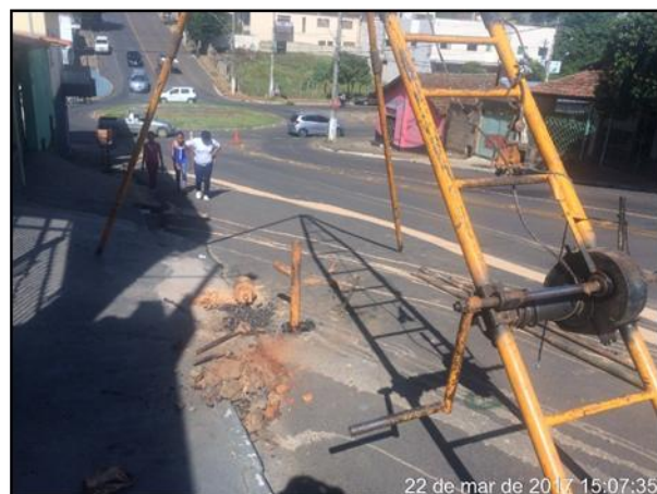
Foto 04 - Sondagem Furo nº3
