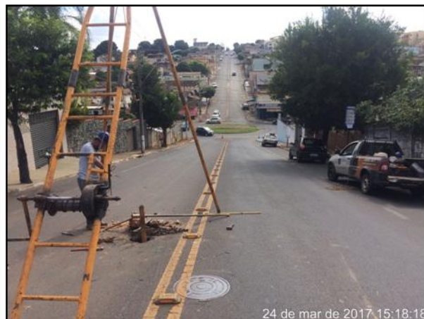
Foto 08 - Sondagem Furo nº12
