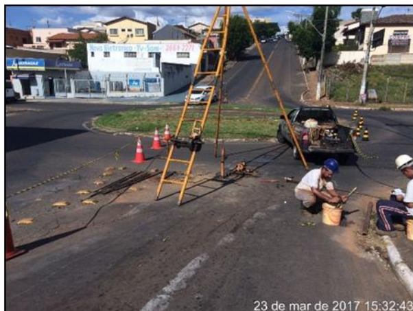
Foto 07 - Sondagem Furo nº 6
