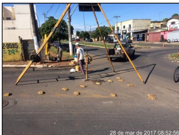
Foto 11 - Sondagem Furo nº7
