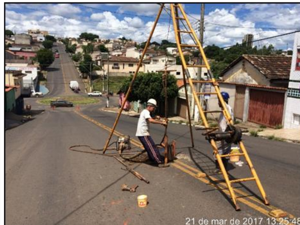
Foto 02 - Sondagem Furo nº2
