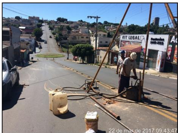
Foto 03 - Sondagem Furo nº1
