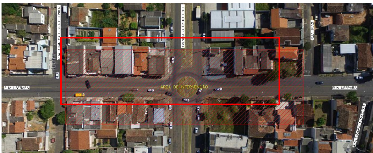
Figura 1 - Imagem de Satélite - Futura localização do Viaduto - Araxá / MG
