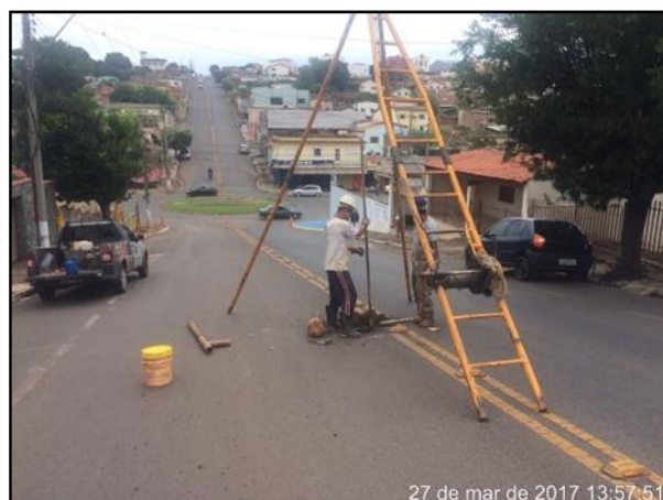
Foto 10 - Sondagem Furo nº11
