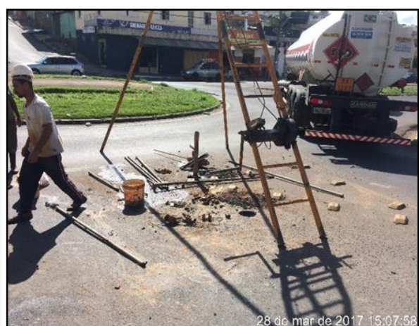
Foto 12 - Sondagem Furo nº8
