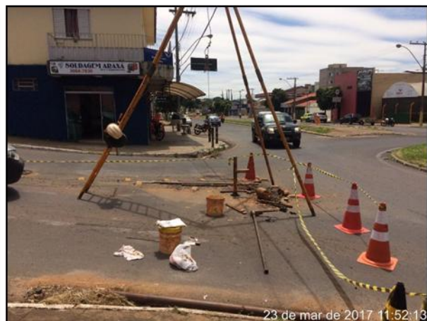
Foto 06 - Sondagem Furo nº5
